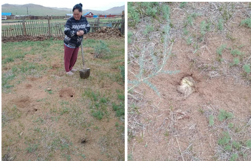
Зураг 81. Оготны нүхэнд барилгын шилэн хөвөн хийсэн байдал
